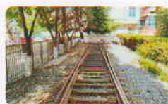
铁路道岔演练场
