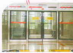
地铁屏蔽门检修实训室
