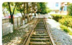
铁路道岔演练场
